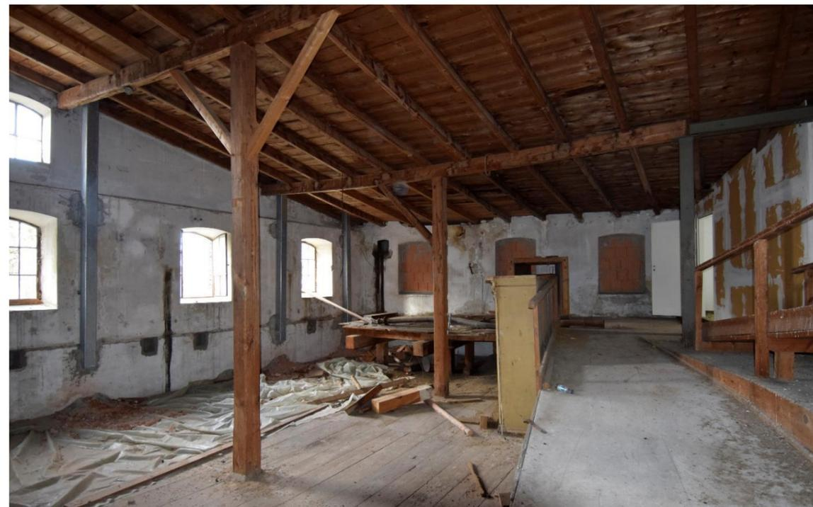
4: Mühlburschenstube. 1. Obergeschoss mit offenem Dachwerk, Blickrichtung Nord-Westen: Pultdach als Holzkonstruktion, auf Unterzügen und Ständer mit Kopfbändern (lokal auch Eisenstützen); einfacher Holzbretterbelag; Fensteröffnungen an der Nordseite vermauert.
