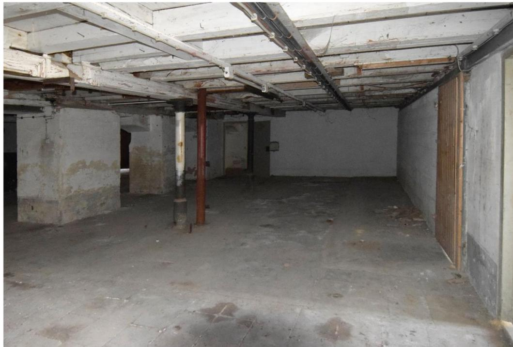
1: Hauptbau, Erdgeschoss, Blickrichtung Norden: Mischkonstruktion aus eisernen (gusseisernen) Stützen und hölzernen Unterzügen, auf denen die Deckenbalken gelagert sind; rechts nachträgliche Trennwand.
