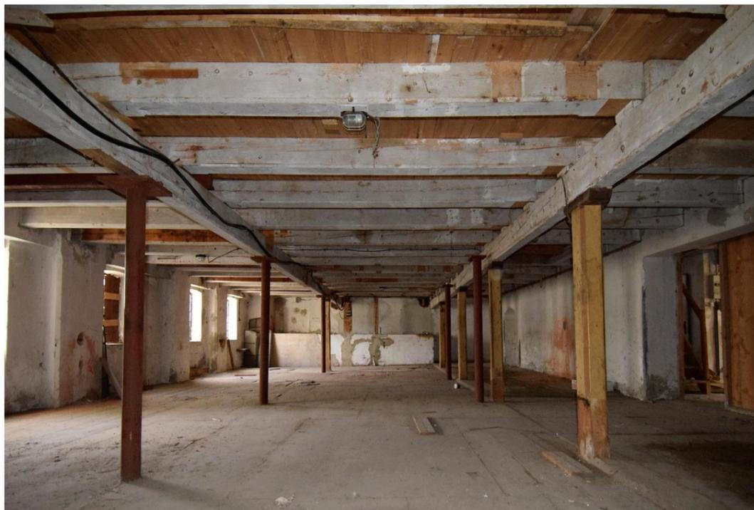
3: Hauptbau, 1. Obergeschoss, Blickrichtung Süden: Ständer (östlichen Reihe überwiegend mit Eisenrundrohr-Stützen ersetzt) und Unterzüge, auf denen die Deckenbalken gelagert sind; zusätzliche Eisenstützen auch beim westlichen Unterzug.
