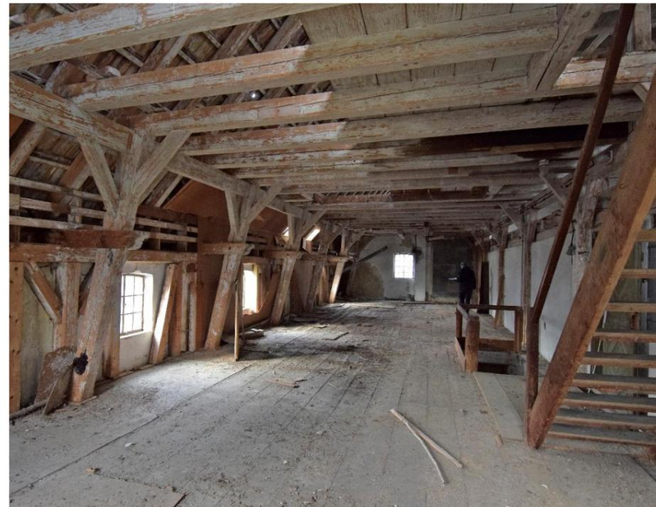
2: Hauptbau, 2. Obergeschoss, westliche Längszone, Blickrichtung Norden: Dachwerk mit liegenden Stuhl - „Einhüftiger Rahmen“; einfacher Holzbretterboden; rechts: Treppenaufgang zum Dachgeschoss.
