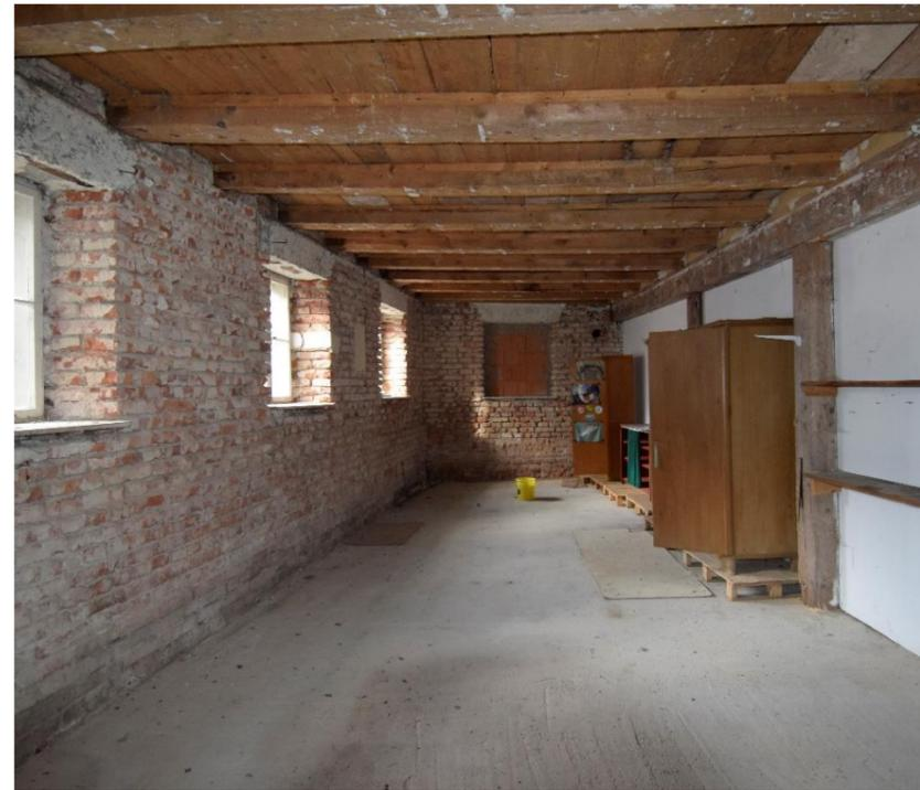
2: Mühlburschenstube, Erdgeschoss, Blickrichtung Norden: Außenwand mit abgeschlagenem Putz; einfache Holzbalkendecke; Fußboden Estrich; rechts Trennwand unter der mittigen Holzständerwand.
