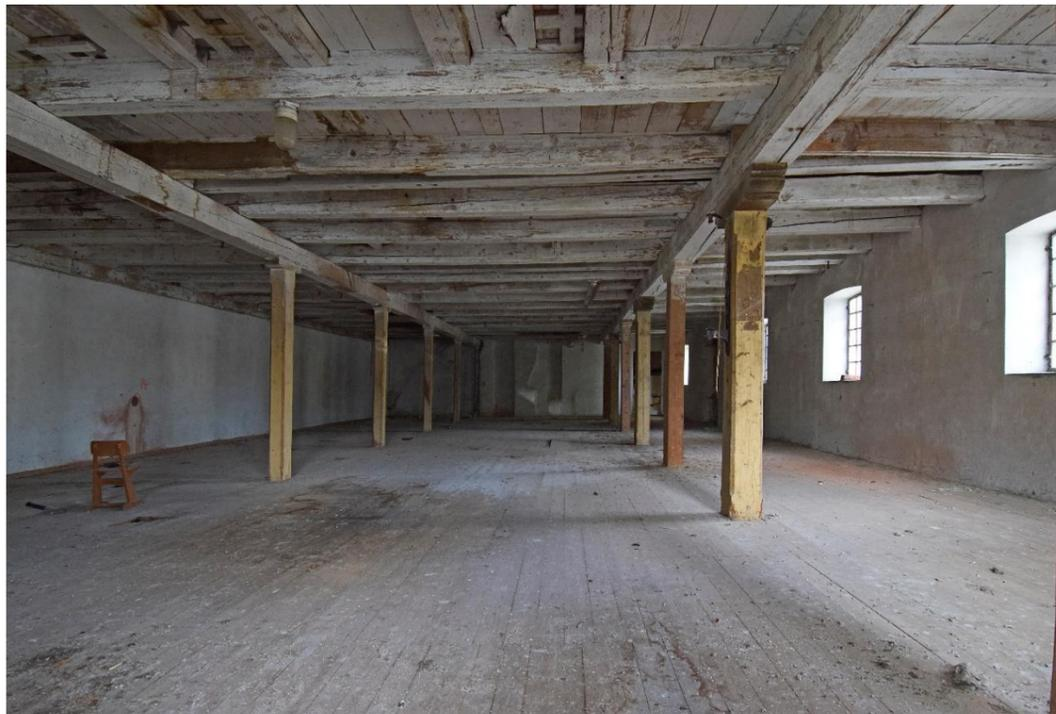
1: Hauptbau, 2. Obergeschoss, östliche Längszone, Blickrichtung Süd: Einfache Holzkonstruktion aus Ständern und Unterzügen, Holzbretterboden.
