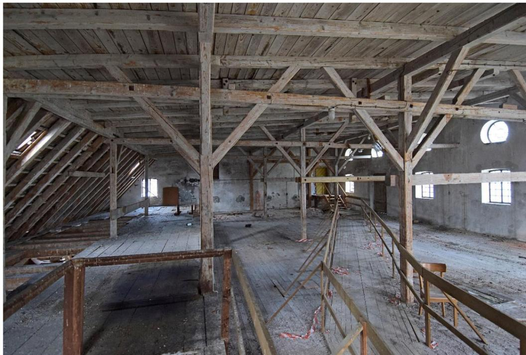
3: Hauptbau, Dachgeschoss, Blickrichtung Nord-Osten: Pultdach mit Pfetten und Ständer mit Zangen und Kopfbändern; Holzrampe diagonal durchgehend; einfacher Holzbretterbelag.
