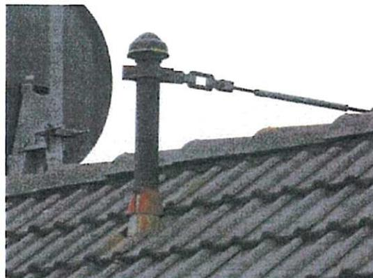
Abbildung 2: Verankerung auf Dachständer
