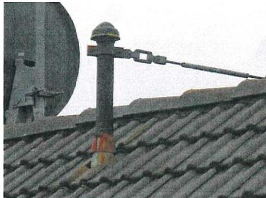
Abbildung 2: Verankerung auf Dachständer
